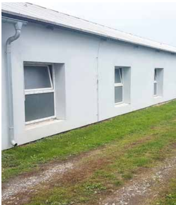
Okna w kurniku po modernizacji
